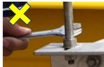
スペーサーの差し込み ピンのピッチ(前傾・後傾)調整に、薄いシム(挟み物)を差し込む例も多く見られます。もし挟むなら、裏側の逆にも挟まなければ、意味がありません。またテレホンカードのような柔らかい素材ではほとんど無意味でまた緩みの原因になります。基本的にはピッチプレートと球面座金のようなセットで調整すべきです。
